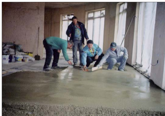
Všetko musí mať svoj rozmer, samozrejme aj dlažba, ktorú budú stavbári vzápätí pokladať na vopred pripravený betónový podklad v spojovacej chodbe vo foyeri, kuchyni aj v časti bufetu budúcej reštaurácie dnešného „Rubína“. Pravdaže oči šéfa boli pri každom úkone, inak to ani nejde.
