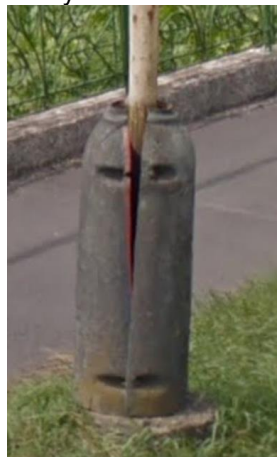
Obr. 2 Poškodená päťka stožiara – potrebná komplexná rekonštrukcia v danej oblasti
