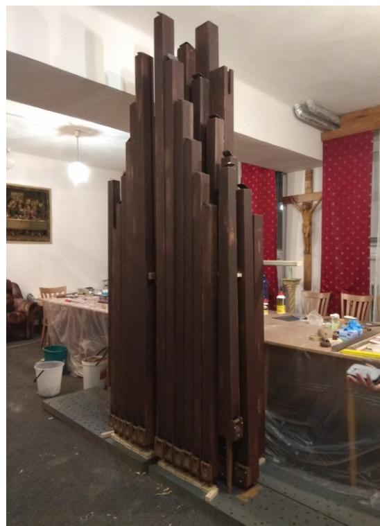
Skúšanie uloženia najväčších drevených píšťal na novom držiaku v dočasnej organárskej dielni
