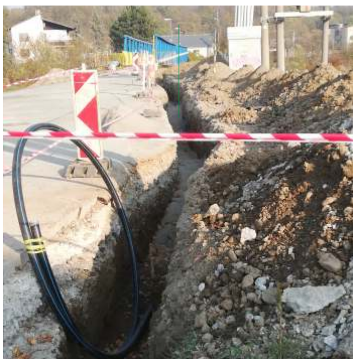
Golianova prepojenie kanalizácie
