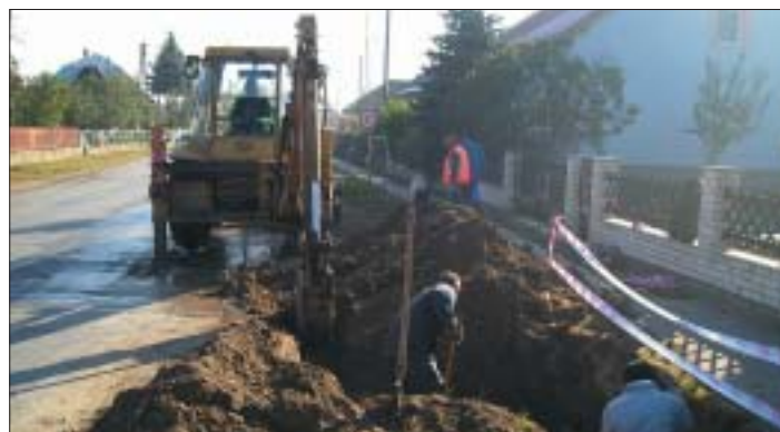
Výkopové práce pre tlakovú kanalizáciu na Ukrajinskej ulici
