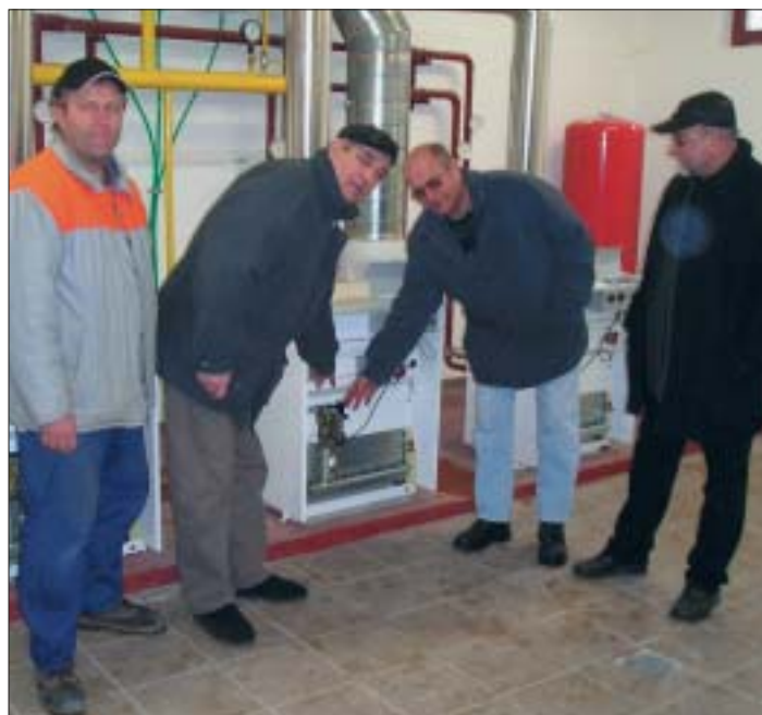
Pri spustení ústredného kúrenia v novostavbe KD, pri ktorom asistujú M. Nagy, druhý zľava nebohý L. Fekete, F. Klik a Ing. R. Ballasch
