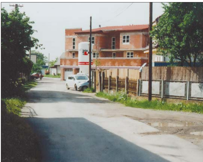
Netradičný pohľad na novú dominantu našej mestskej časti – polyfunkčný objekt. Po ukončení vonkajšej časti stavby na rade je interiér – omietky, elektroinštalácia, plynoifikácia a ďalšie odborné práce. Foto: (bič)
