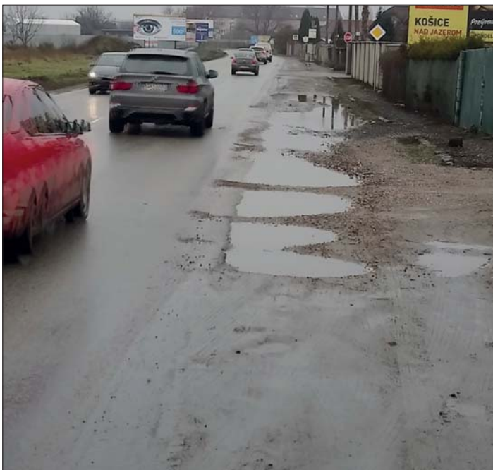
Chýbajúca dažďová kanalizácia na Ukrajinskej ulici. Štúdiá riešenia zahrnutá do programového rozpočtu na rok 2018.
