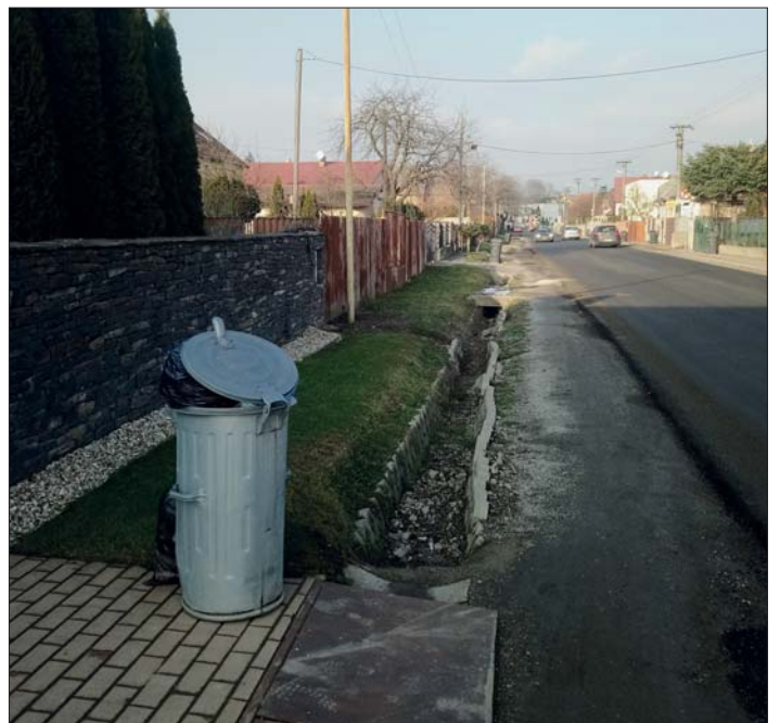
Napriek novému asfaltovému koberec ešte chýba ukončenie dažďovej kanalizácie a výstavba nového chodníka na Minskej ulici.
