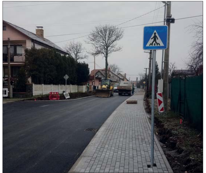
Komplexná obnova Prašnej ulice s vybudovanými chodníkmi a dažďovou kanalizáciou
