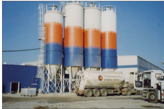
Pohľad na novovybudovaný objekt plneautomatizovanej betonárky krásňanskej firmy PEVA, ktorá modernou technológiou vyrába všetky druhy betónovej zmesi s kapacitou päťdesiat kubíkov za hodinu.
