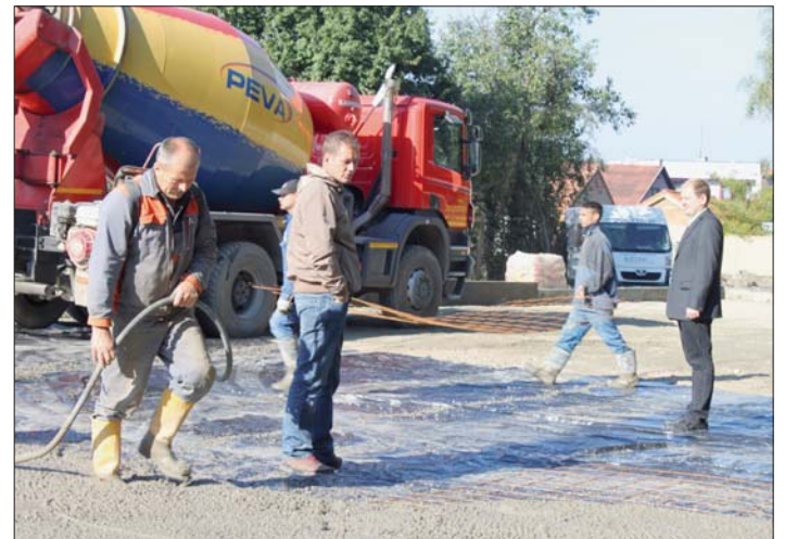
„Peváci“ nezabúdajú ani na pomoc obci, v ktorej pôsobia. Naposledy tak urobili pri dovoze betónovej zmesi na budúcu oddychovú zónu. Na betonáž ihriska s našim starostom dohliada aj šéf firmy PEVA.
